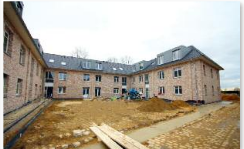
Hier wächst was: Bauprojekte in Oberforstbach (oben) und Aachen (unten). Foto: IK Aachen
